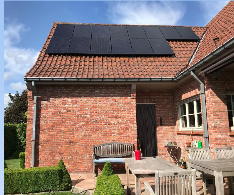
Sistem fotovoltaic ON-GRID • 5 kW putere instalata
